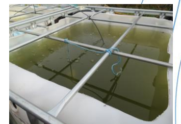
Lammin biologisen aseman kasvatuskokeessa havaittiin, että jätevesien puhdistusta voidaan tehostaa levien avulla.
