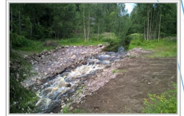
Renkajoen Nevilänkosken patoa korjattiin syksyn tulvien jäljiltä lisäkiveämällä.
