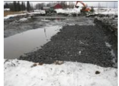
Äimäjärven Kutisten kosteikkoallasta rakenteilla maaliskuussa 2012.
