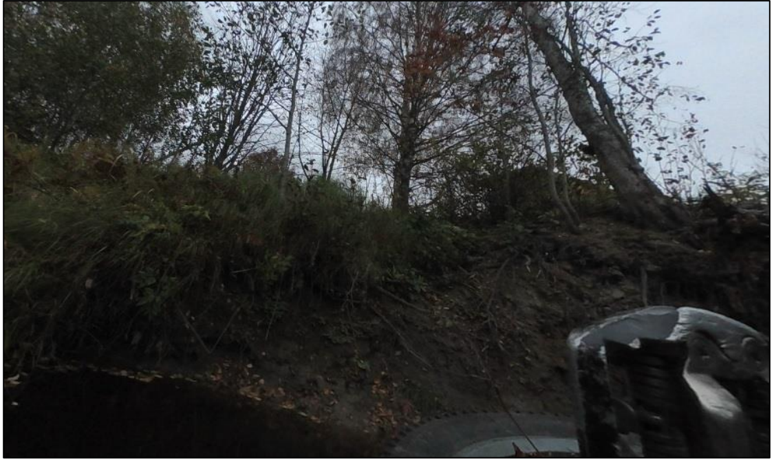
Kuva 4. Teuronjoen penkassa havaittu keskisuuri sortuma.
