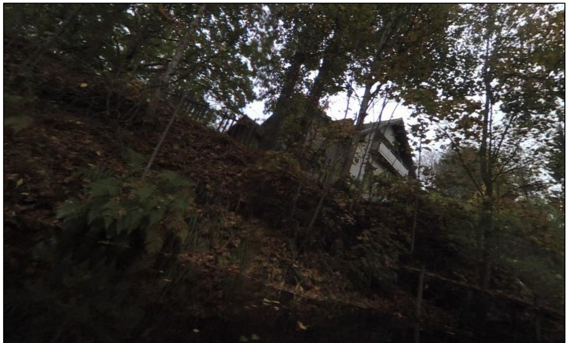
Kuvat 11 ja 12. Jokelankosken alapuolella sijaitseva ehdotettu toimenpidekohde. Ylemmässä kuvassa punaisella vinoneliöllä osoitetulle kiinteistölle aiheutuu voimakkaasta uomaeroosiosta johtuva välitön uhka. Alemmassa kuvassa otos kiinteistön rantavyöhykkeeltä.
