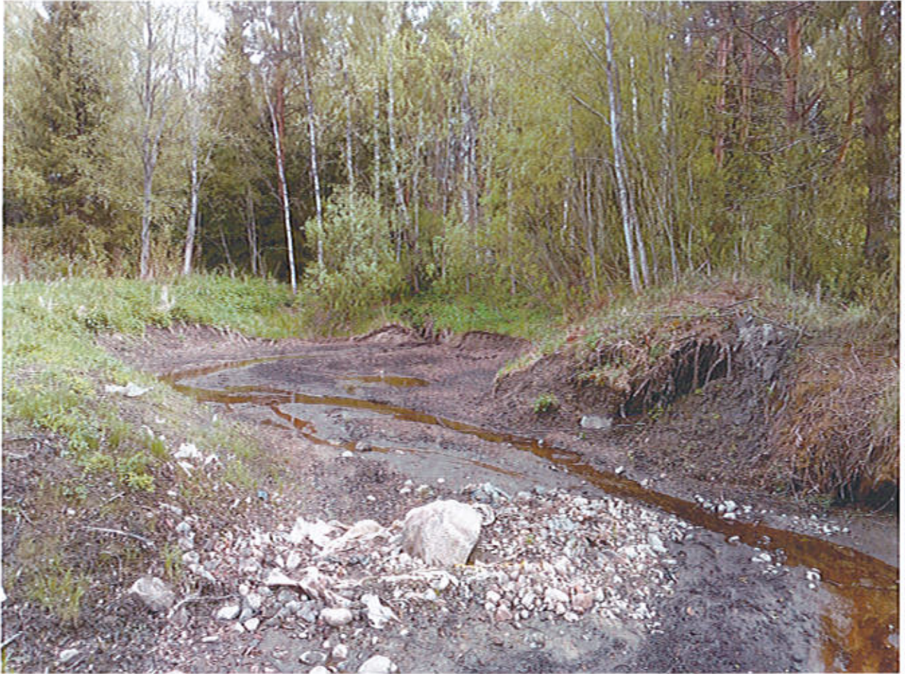
Kuva 5. Allas 2. Altaassa on vanhan, puretun padon jäänteet. Vesi söi aikoinaan tiensä ohi vanhan padon. Vesi on päässyt myös oikealla olevan penkereen alle, joten se on huomioitava kaivutöitä ja "siistimistä" tehtäessä.
