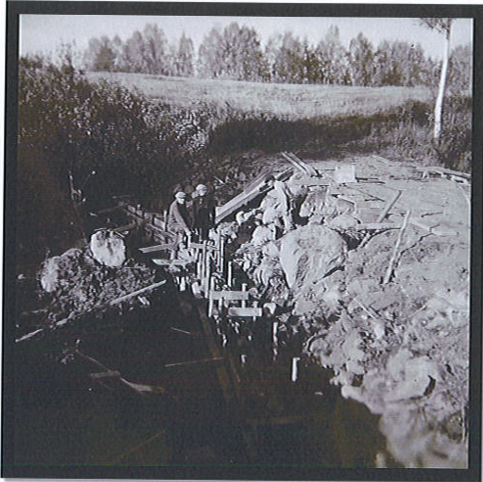
Kuva padon rakennustöistä todennäköisesti 50-luvun loppupuolelta kunnostuksen kohteena olevalla kosteikolla
