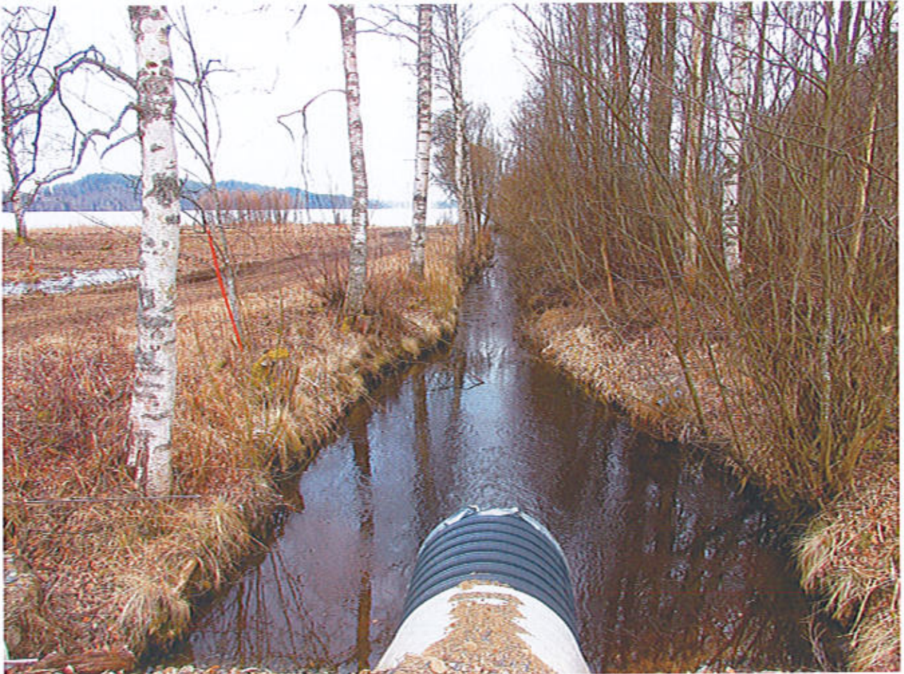
Kuva 7. Uoma tällä hetkellä siltarummun päältä kuvattuna. Tarkoituksena on ohjata rummusta tulevat valuma-alueen vedet kuvassa vasemmalla näkyvälle alueelle, jonne rakennetaan kosteikko.
