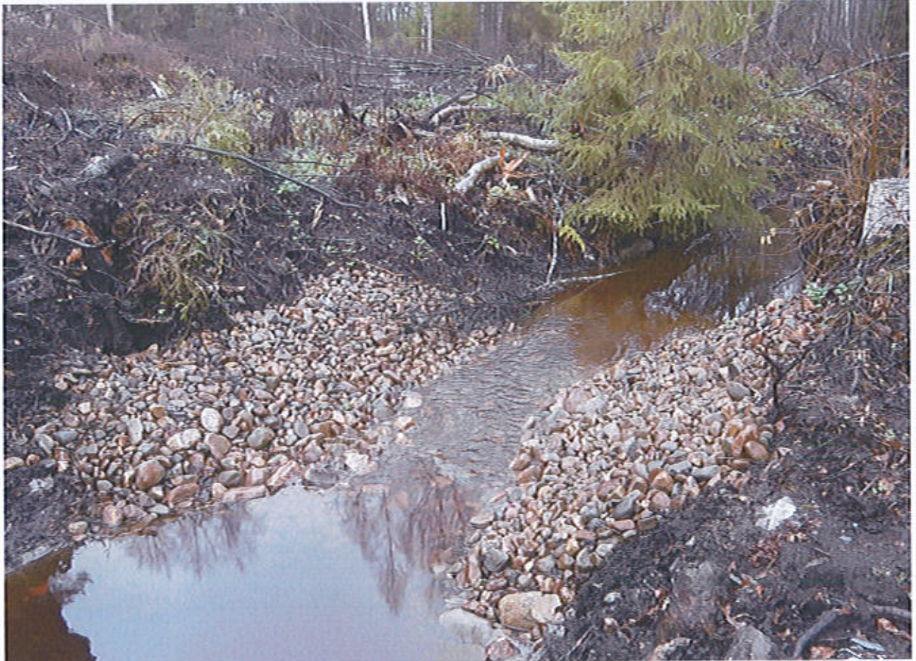
Kuva 2. Ojat kuntoon-hankkeessa toteutettu pohjakynnys metsäojassa. (Lähde: http://www.hameenraitti.fi/uutiset/ojat-kuntoon-kestavasti-kanta-ja-paijat-hameessa/ )
