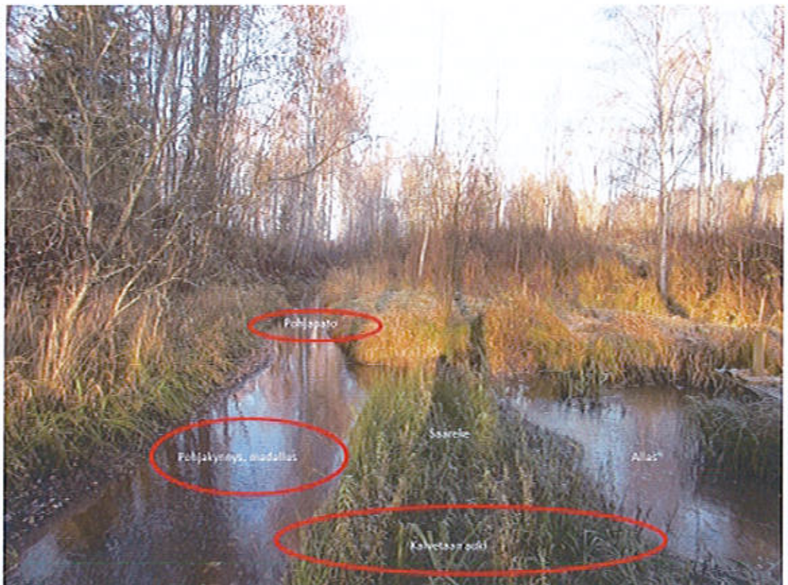
Kuva 2. Kuvaan on piirretty pohjapadon, pohjakynnyksen eli madalluksen, jätettävän saarekkeen sekä kaivettavan väylän kuten myös olemassa olevan altaan sijainnit. Kuvassa suoraan menevä oja on Lovonoja, kuva on otettu noin paikalla olevan vanhan pumpun kohdalta. Kuvassa oikealle laskee toinen laskuoja.
