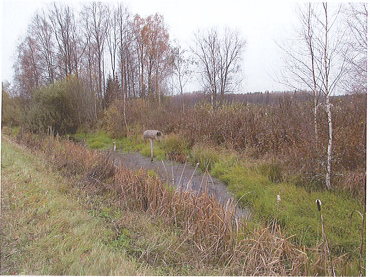
Kuva 8. Uomassa olemassa oleva allas. Altaan kunnostamiseen kuuluu kasvuston perkaus sekä laajennus kuvan taka-alalle. Allas toimii sekä vesiensuojelullisesti keräten valuma-alueelta kiintoainesta sekä ravinteita, mutta myös vesilintukosteikkona. Altaaseen on laitettu sorsalinnuille sopivia pesäpaikkoja.
