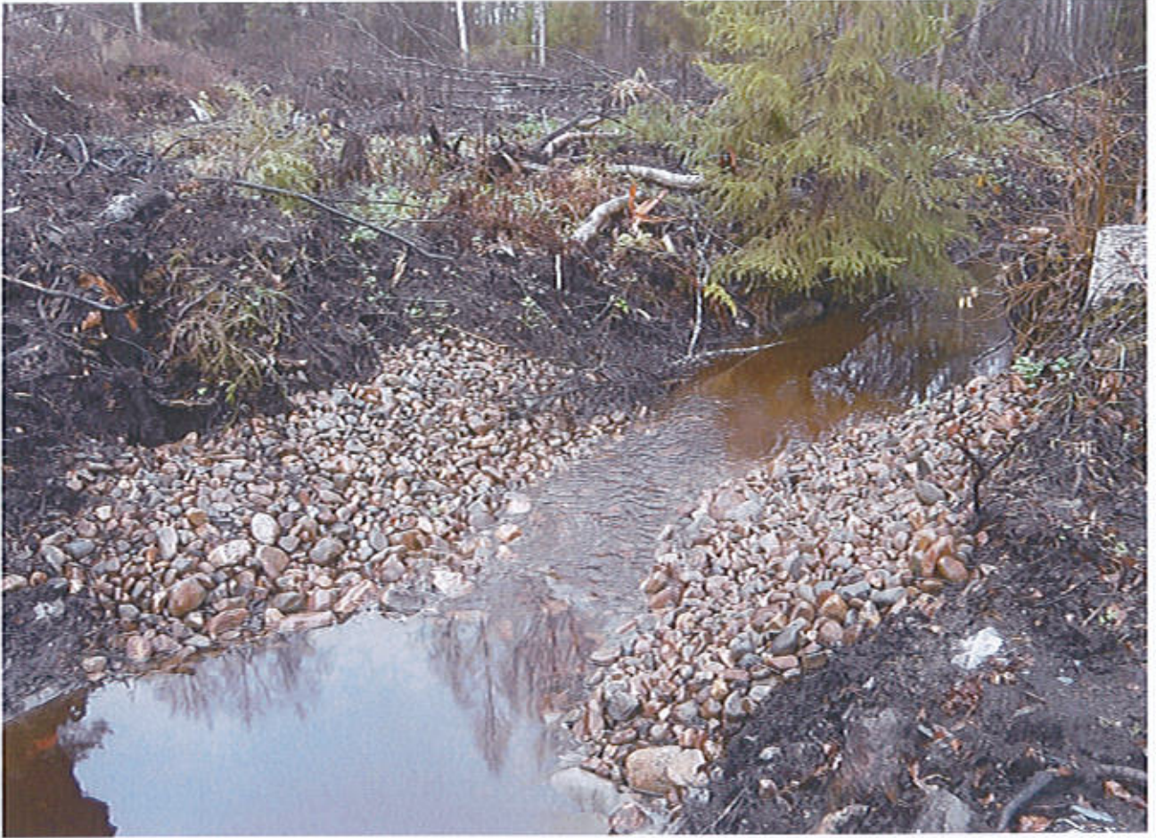
Kuva 5. Ojat kuntoon-hankkeessa toteutettu pohjakynnys metsäojassa. Tällä samalla periaatteella luonnonkiviä hyödyntäen voidaan rakentaa sekä pohjapato että pohjakynnys. (Lähde: http://www.hameenraitti.fi/uutiset/ojat-kuntoon-kestavasti-kanta-ja-paijat-hameessa/ )
