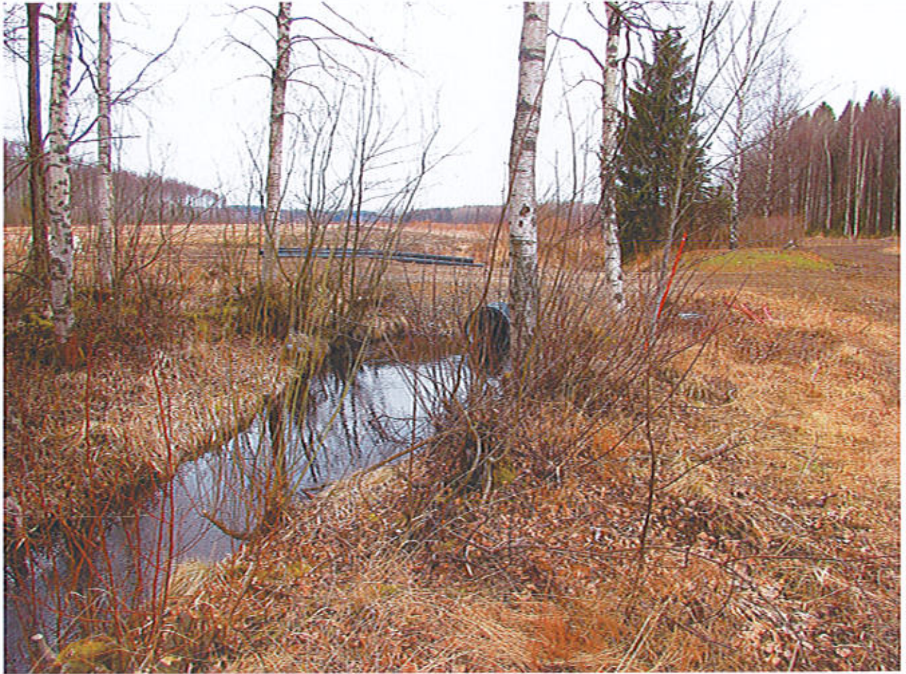
Kuva 5. Uoma rakennettavan kosteikon alkupäässä. Tästä vesi ohjataan heti sillan rummun jälkeen toisen rummun kautta kaivettavaan kosteikkoon. Uomaan muotoillaan pohjapato, joka ohjaa veden kosteikkoon sekä toimii ylivirtapatona mahdolliseen tulva-aikaan.
