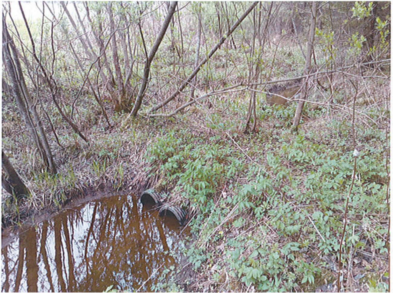
Kuva 9. Vanha ylityspaikka ja siinä olevat putket. Tämä kohta voidaan avata, jolloin estetään putkien mahdollinen tukkeutuminen.
