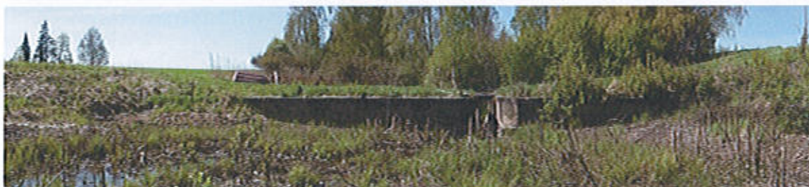
Kuva 4. Vanha pato kuvattuna altaan eli yläjuoksun puolelta. Keskellä näkyy patoaltaan tyhjennyskanava.
