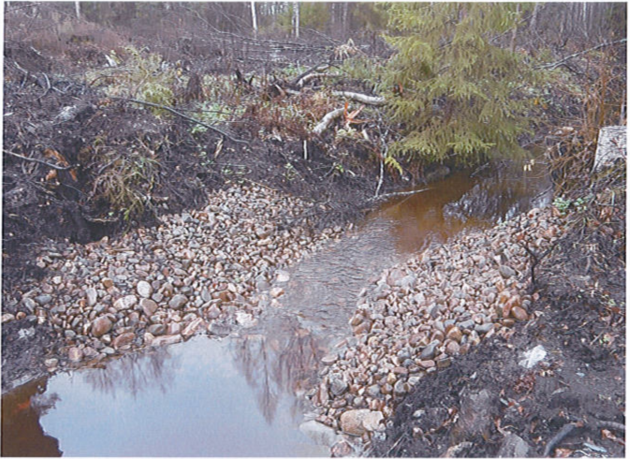
Kuva 5. Ojat kuntoon-hankeessa toteutettu pohjakynnys metsäojassa. (Lähde: http://www.hameenraitti.fi/uutiset/ojat-kuntoon-kestavasti-kanta-ja-paijat-hameessa/ )
