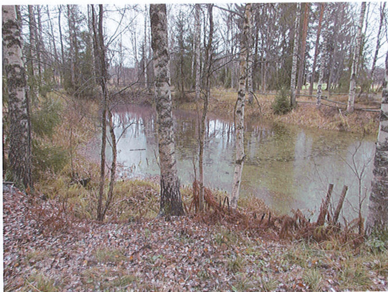
Kuva 11. Pihapiirissä oleva allas. Vanhat putkien paikat on etsittävä ja mahdollisuuksien mukaan uusittava. Poistopäässä toimii hyvin ylivuotoputki.
