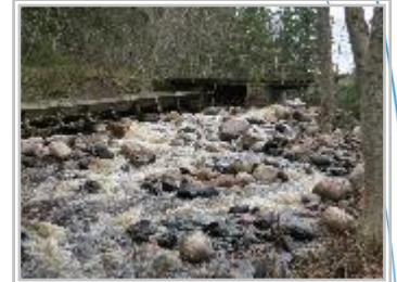
Renkajoen Hiittan vanha säännöstelypato muutettiin pohjapadoksi. Nyt kalat pääsevät padon ohi ylävirtaan.
