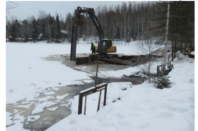
Janakkalan Vääräkosken vanha luukkupato korvattiin pohjapadolla.
